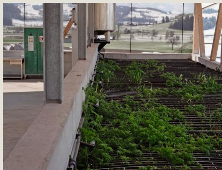
Das Biobac besteht aus einer Schicht aus Humus, Kompost und Häckselstroh. Darin werden Mittel-Rückstände abgebaut.
